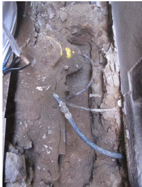
10. Cablejat elèctric davant la finca núm. 3.
