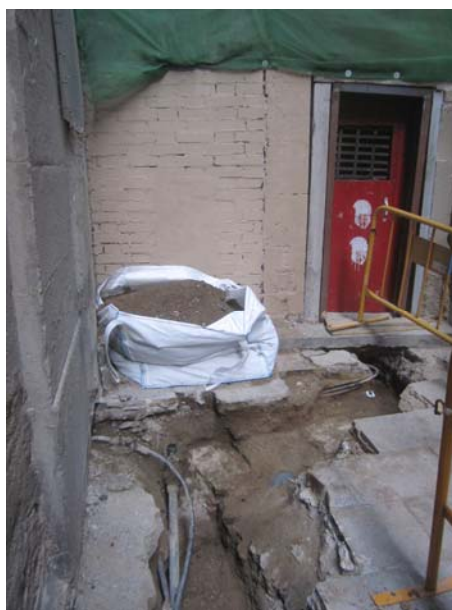
8. Ubicació del mur UE 3 a l'extrem nord-oest de la rasa.
