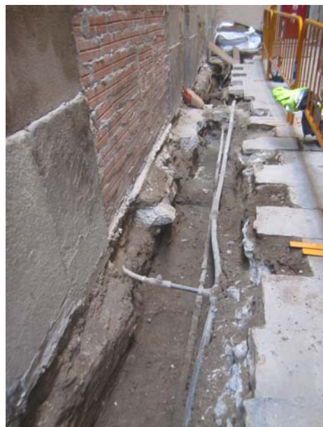
12. Vista general de la rasa.
