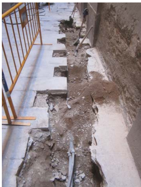
3. Inici dels treballs d'obertura de la rasa.
